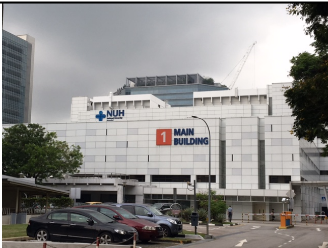
醫院見習—NUH 總共有三棟建築環環相連，這是第一棟大樓。
